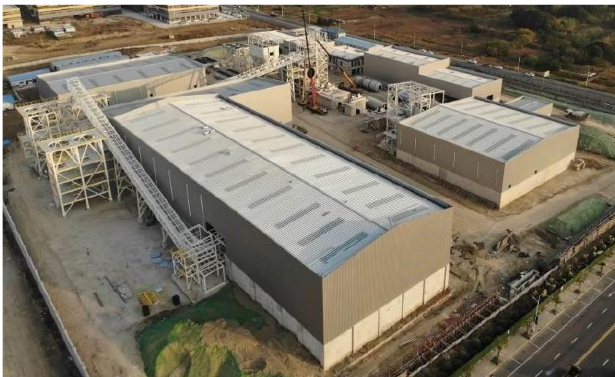
Vista aérea de la construcción de Changzhou, provincia de Jiangsu, noviembre de 2020
